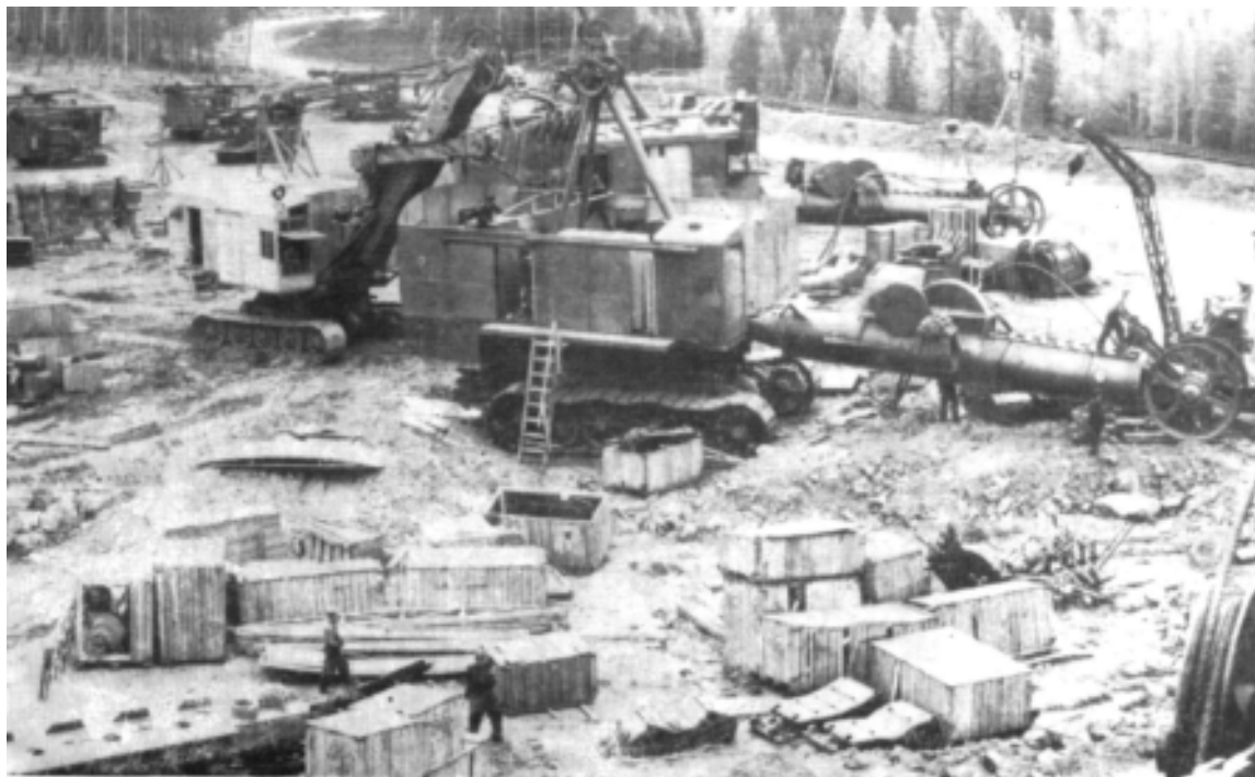
Сборка первых экскаваторов в карьере.
