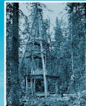
Одна из первых геологоразведочных вышек на горе Качканар
