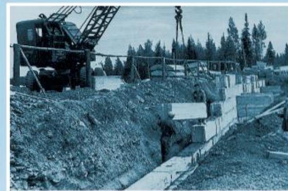
▲ Строительство больничного городка, начало 1960-х гг.
