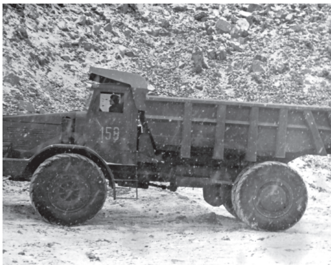
МАЗ-525. Окончание выемки грунта корпуса крупного дробления 1962 г.
