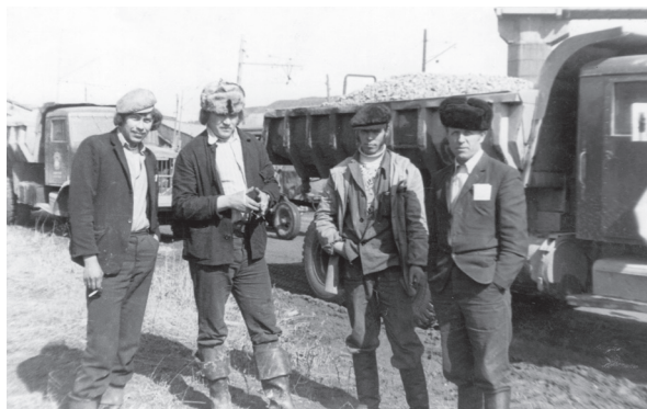
На строительстве автодороги Свердловск – Серов. Брюхов, Ковшов, Южанин, Воробьёв А.В.
