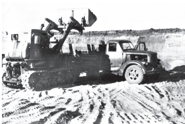
Автосамосвал Урал-ЗИС-355 с механическим приводом подъёма кузова. На этой машине Т.Ф. Дралов работал с 1958 по 1963 г.
