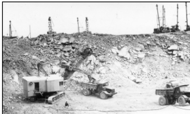
Первое поколение экскаваторов - «ЭКГ-4» грузит 25-тонные «четвертаки». Вверху на горизонте справа: станки КУБ; слева - бурстанки нового поколения.
