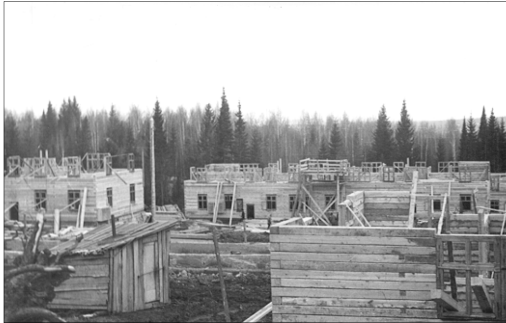
Конец 50-х. Начало строительства улицы Октябрьской.
