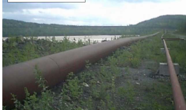
Водовод для сброса уровня паводковых вод Нижневыйского водохранилища
